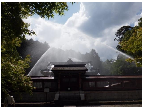
設置した消火設備の放水訓練
