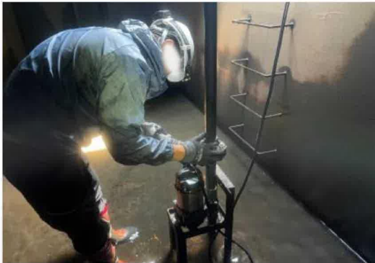
処理水監視槽内にポンプ設置
