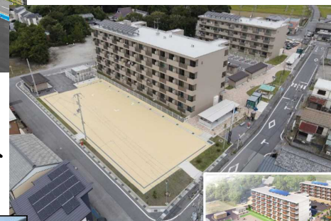
完成写真 (ドローンによる空撮)
