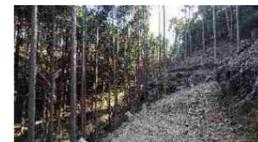
木材生産のための作業道は、土砂流出を抑えるために線形や縦断勾配に配慮して設計がされ、水が走らないように水切りがされています。
