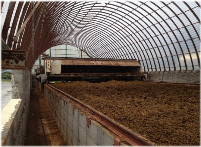
発酵堆肥化施設
