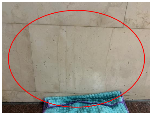
雨水が染み出した壁面
