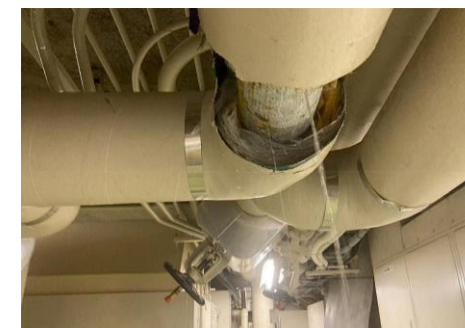
空調設備の配管が錆により欠損し水漏れが発生
