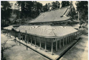
修理竣工時のガラス乾板
