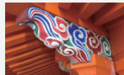
持送の施工完了
