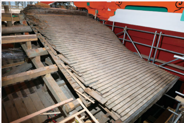
南北の車寄に残る江戸時代と推定される栩板
