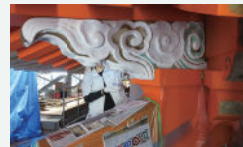
残存塗膜を剥落止めた後、 胡粉地を引いた状況
