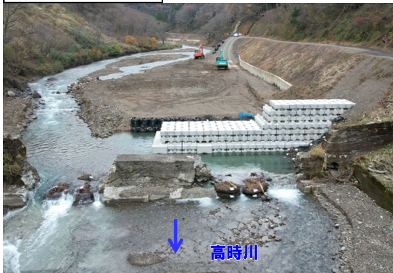
施工状況(R6.12)
