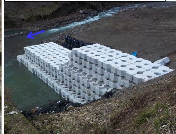
左岸側ブロック設置状況(R6.12)
