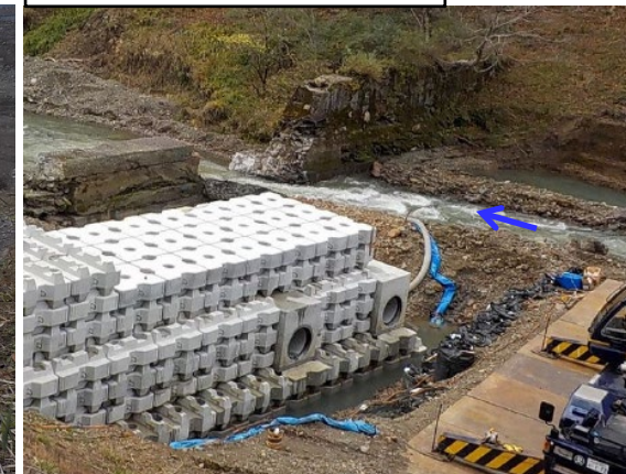
魚道設置状況(R6.11)
