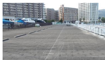
マリーナ桟橋取付護岸
