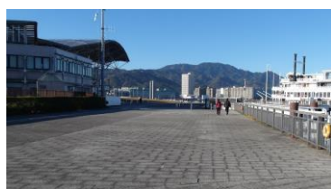
大型浮桟橋取付護岸
