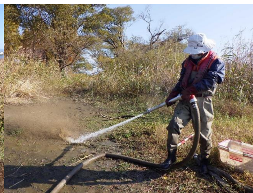
水中ポンプを用いた根茎の掘り起こし
