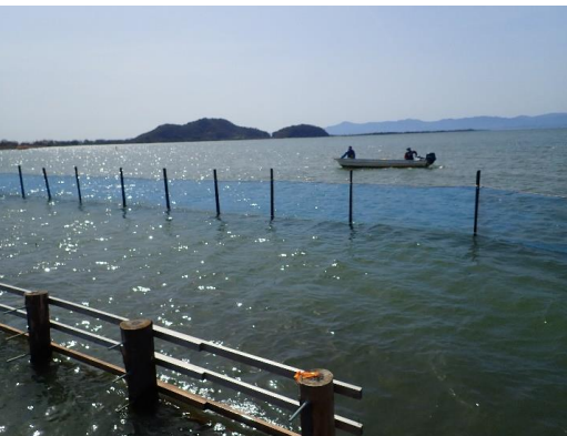
ヨシ造成地の沖側に設置したネットフェンス(高さ4m)
