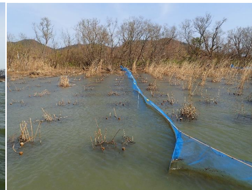
ヨシ造成地内に設置したネットフェンス(高さ1m) ※沖側から陸側を望む
