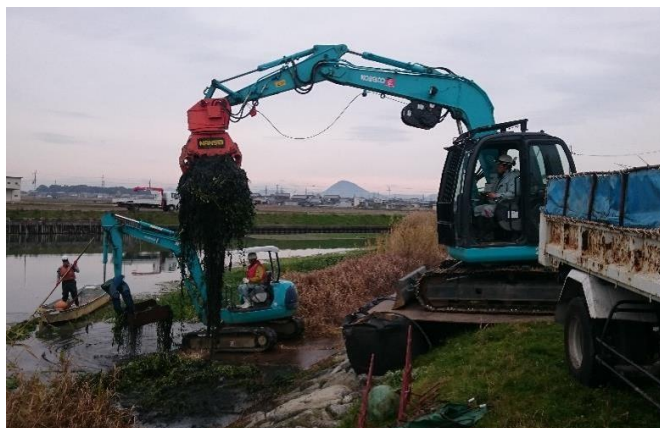
陸地からの建設機械による駆除
