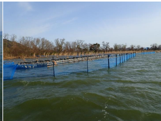
ヨシ造成地の沖側～側面に設置したネットフェンス(高さ4m)
