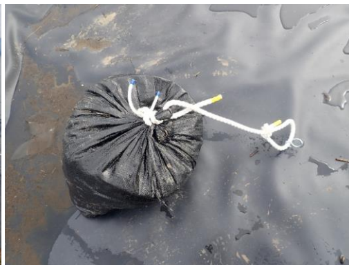
シートの移動、捲れ防止のための土嚢
