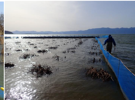
ヨシ造成地内に設置したネットフェンス(高さ1m) ※陸側から沖側を望む
