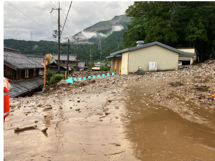
令和6年7月25日土砂流出（3回目）
