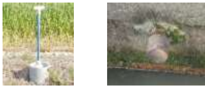
図1 暗渠排水栓と暗渠排水口の一例
