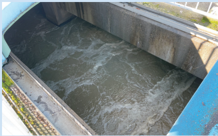
③生物反応槽 下水に活性汚泥(好気性微生物を多量に含んだドロ)を加え、空気を吹き込んでばっ気します。この間に微生物は下水中の汚物を食物として繁殖し、汚物は綿毛状のかたまりとなって沈殿しやすくなります。生物反応槽は無酸素槽と好気槽に分かれており、主として有機物と窒素を除去します。
