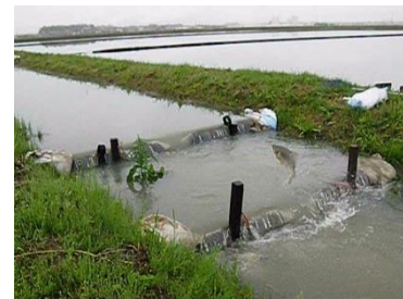
湖魚が遡上するための 堰上式魚道
