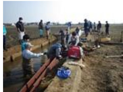
魚道の設置作業
