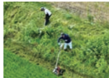
棚田法面の草刈り
