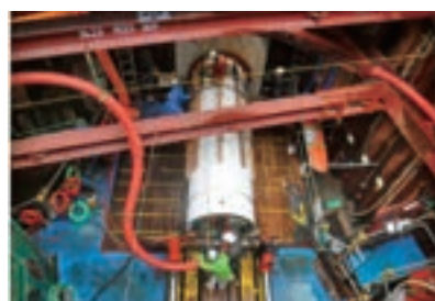
管水路の保全更新
