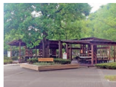
びわ湖材を使用した施設 （龍谷大学瀬田キャンパス）
