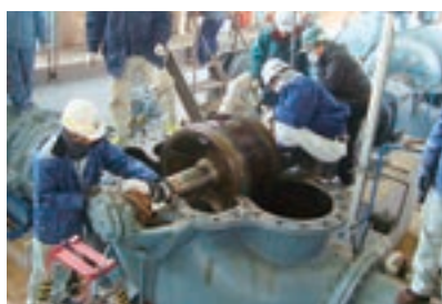
ポンプの機能診断
