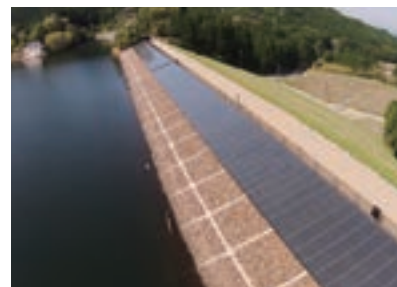
ため池法面での太陽光発電
