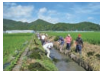
水路の泥上げ
