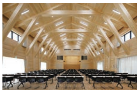
びわ湖材を使用した施設 （「鹿深ホール」 みなくるプラザ）
