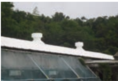
屋根への消石灰の塗布
