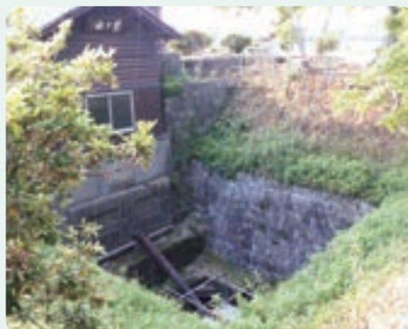
龍ヶ池の取水井戸
