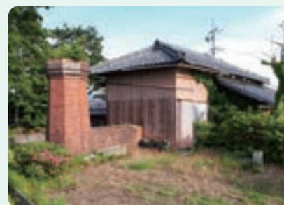
龍ヶ池揚水機場
