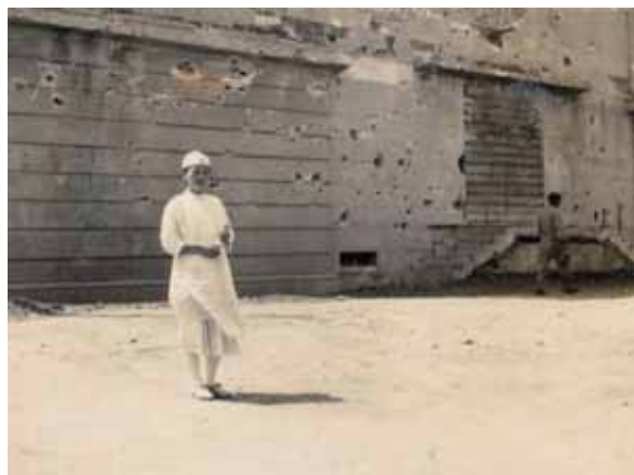
南京病院にて 建物の壁は銃弾の跡だらけです
