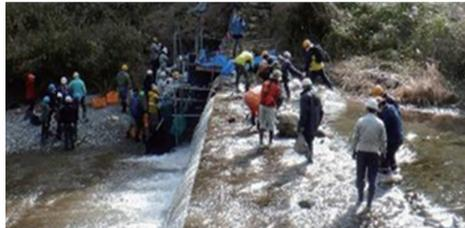
写真9-8-1 手作り魚道の制作の様子
