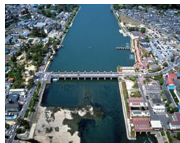
写真9-6-1 瀬田川洗堰 (出典:琵琶湖河川事務所HP)
