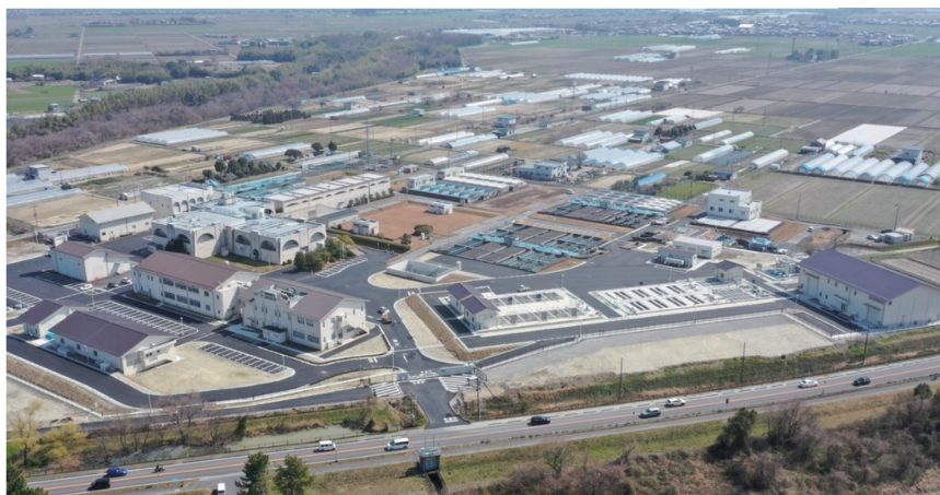
写真9-2-1 琵琶湖から取水する吉川浄水場
