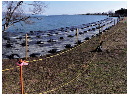
写真7-11-5 石積み護岸を覆うように敷設された遮光シート
