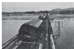
写真3-8-3 当時の様子 (大津市瀬田川鉄橋上)
