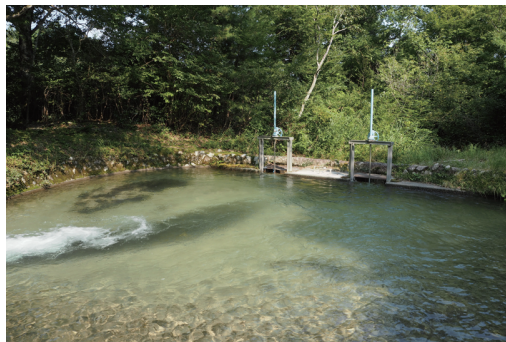
写真3-7-3 比良山麓にみられる沈砂池
