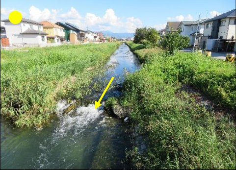
野瀬川橋より上流 (R5.9 撮影)
