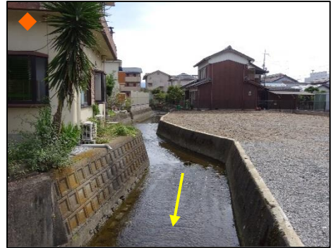
平田橋より上流 (R5.10 撮影)
