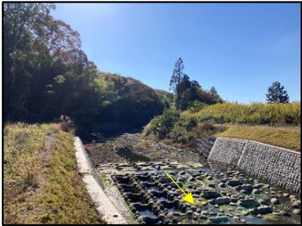
矢倉川上流部(護岸工整備) (R5.11 撮影)
