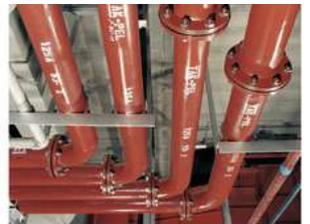
ツリーだけでなく**周辺の商業施設一体の熱供給システム**にも使用されています。
