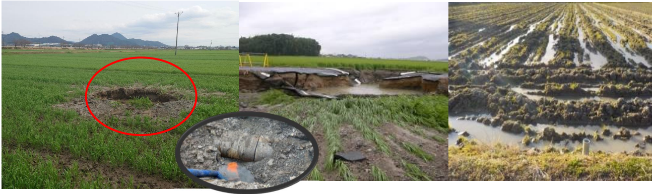
圧送管破損漏水事故による被害状況
