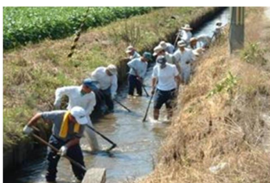
排水路の泥上げ
