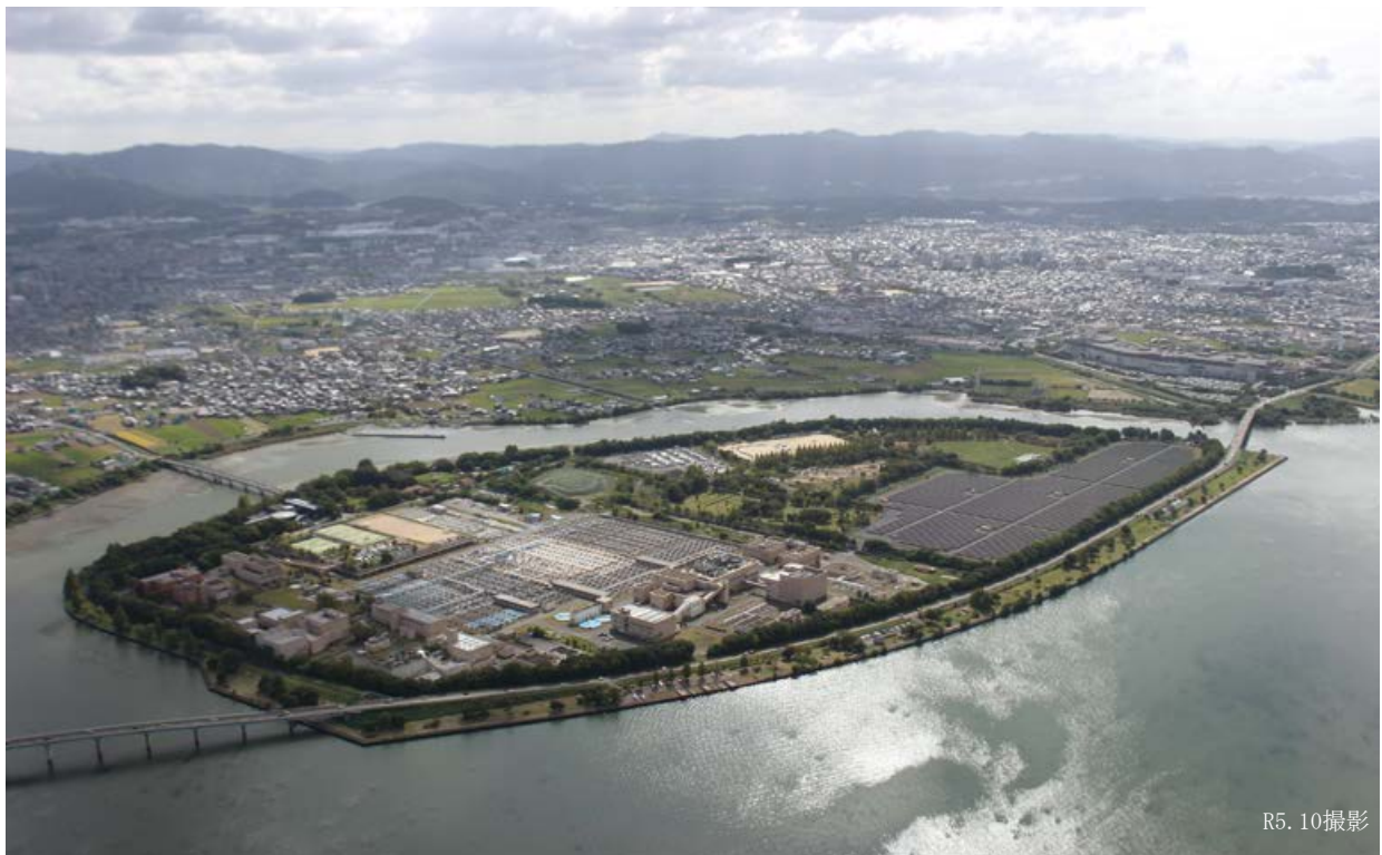
▲湖南中部浄化センター（草津市）
