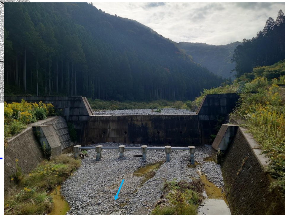
完成済みの砂防堰堤
