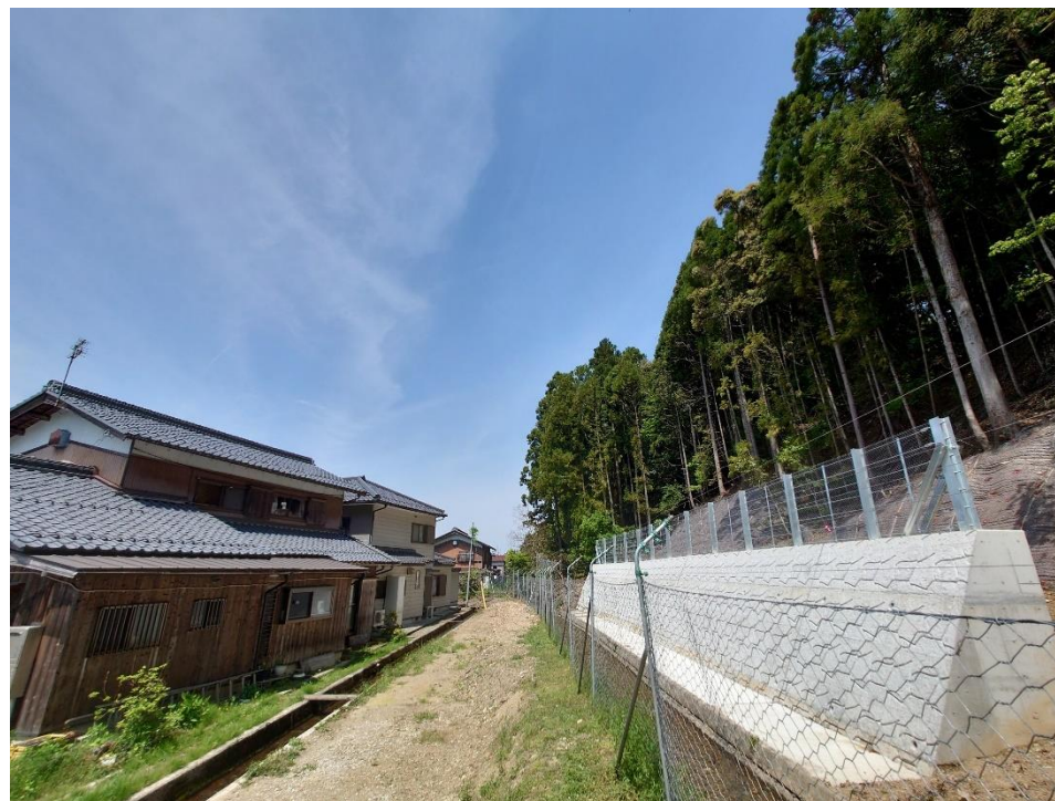
重力式擁壁工 完成状況
