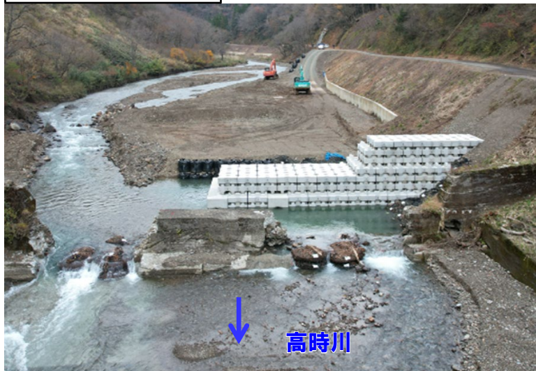
施工状況(R6.12)
