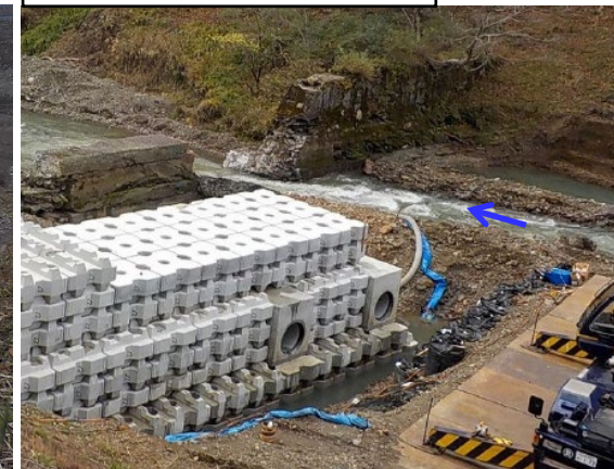
魚道設置状況(R6.11)
