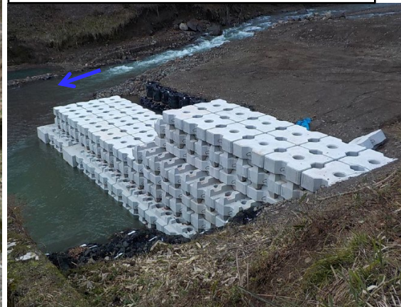
左岸側ブロック設置状況(R6.12)
