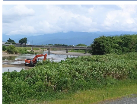
重機による河床耕耘 （主に、砂利の間や滞留した場所にたまった泥を流す効果を期待）
