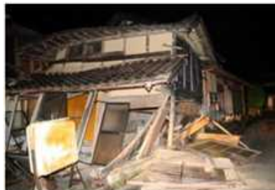
倒壊した建物＝志賀町矢蔵谷 北國新聞 2024年1月3日
