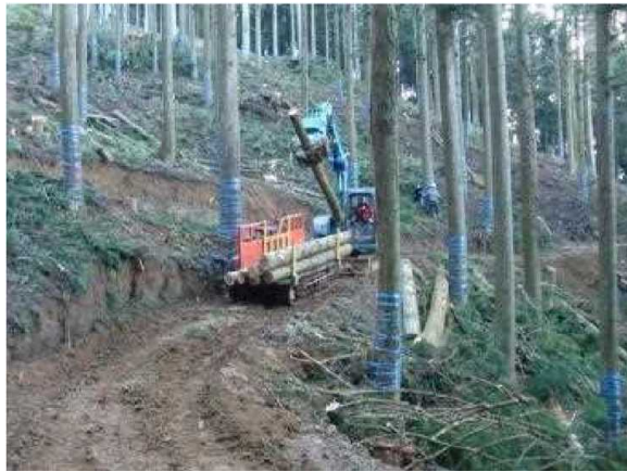
【図表2-10】間伐施工地（長浜市）
