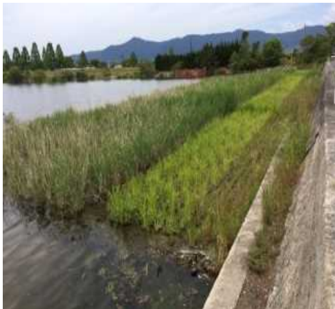
【図表1-19】底質改善対策（覆土工・植生工）
