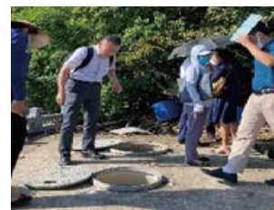
ベトナムでの浄化槽設置
