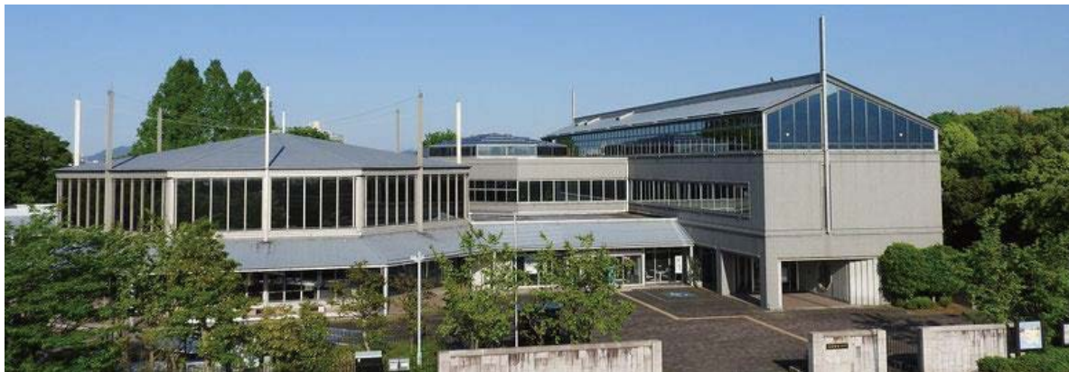
淡海環境プラザ外観
