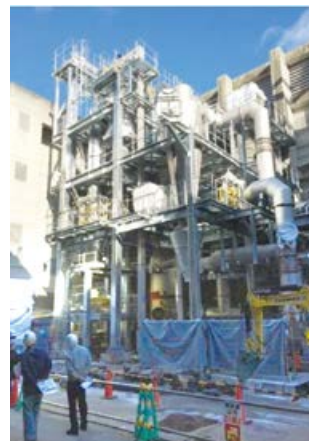
燃料化施設外観
