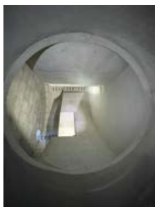
出度3工区マンホール内部
