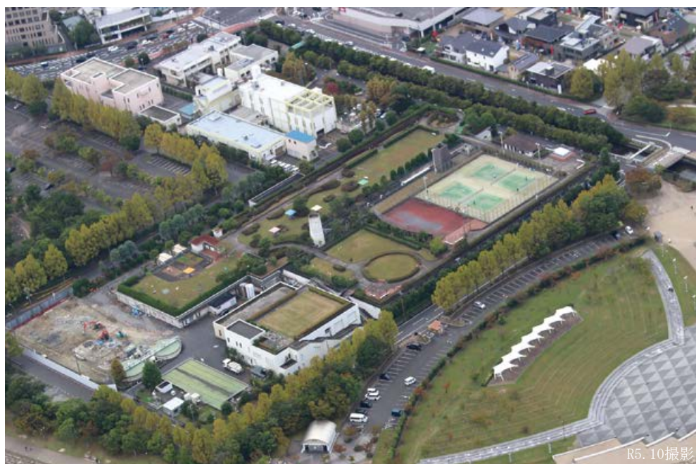
▲大津市水再生センター
