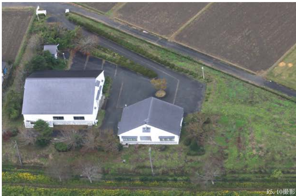
▲高島市朽木浄化センター
