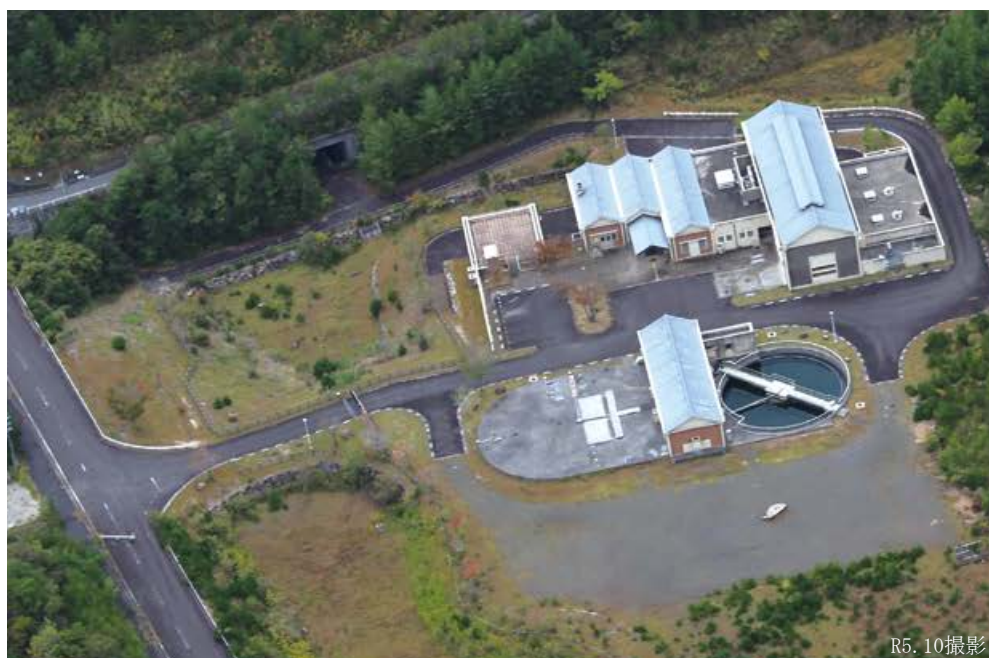
▲甲賀市信楽水再生センター
