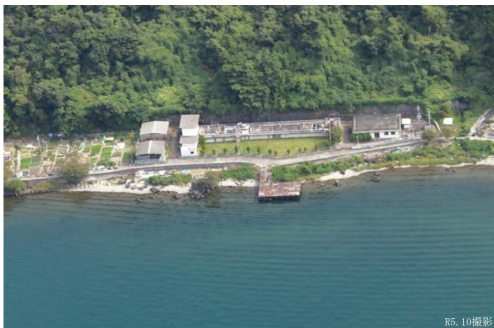
▲近江八幡市沖島浄化センター
