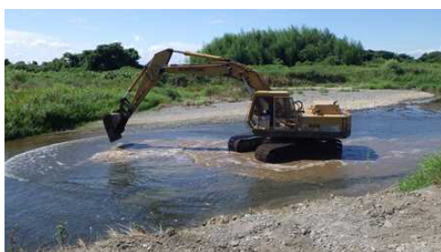
重機による耕耘 （主に、固くしまった河床を柔らかくする効果を期待）
