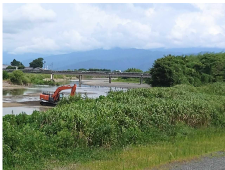
重機による河床耕耘 （主に、砂利の間や滞留した場所にたまった泥を流す効果を期待）
