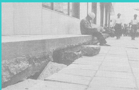
地盤沈下によるビルの蹴上がり
