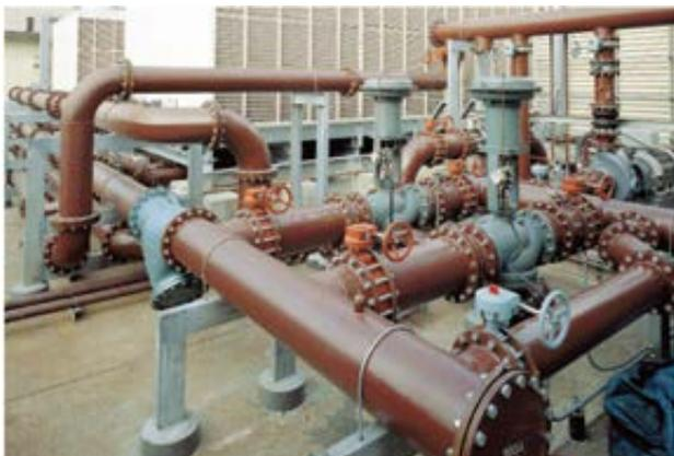
耐食鋼管（塩ビライニング鋼管の現地配管）
