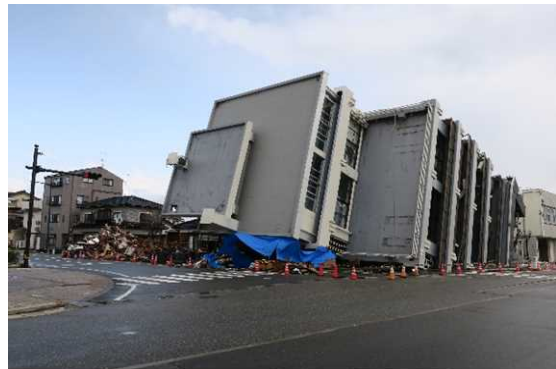
被災状況(輪島市)
