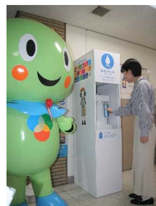
△県庁舎に設置した給水機
