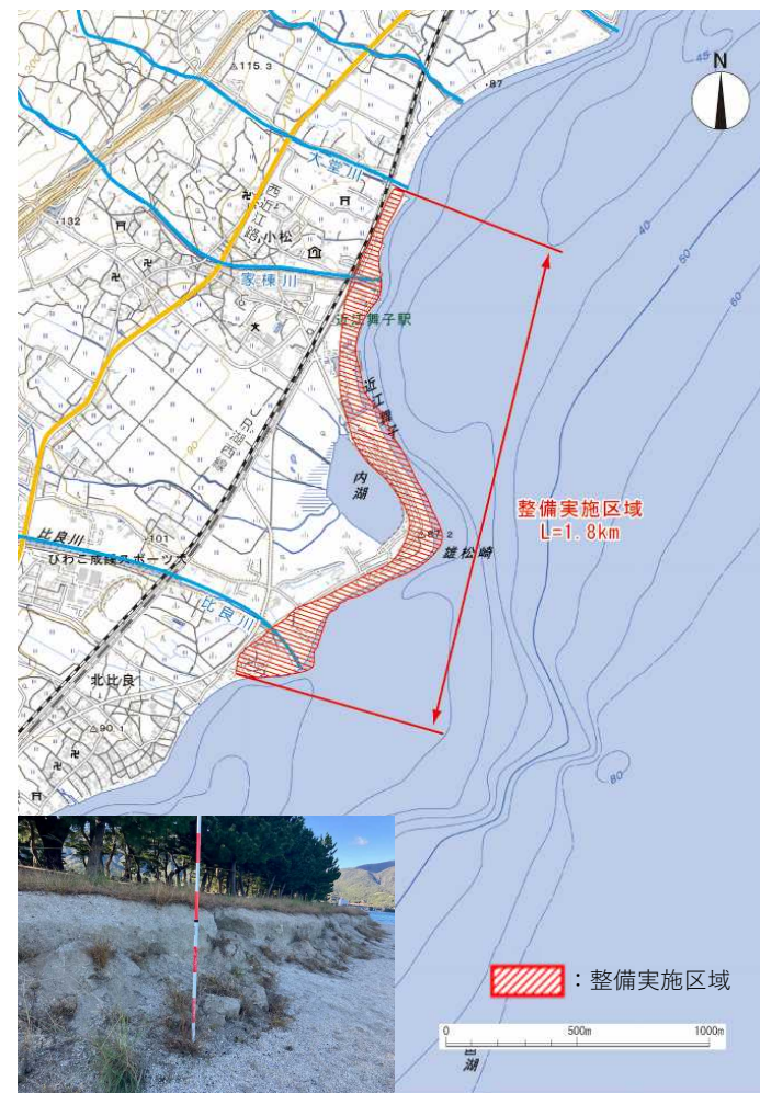
侵食による浜崖
