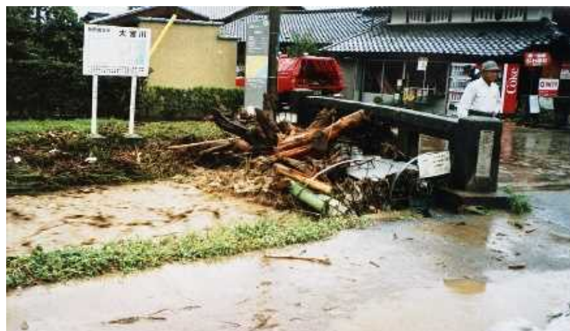
平成9年8月5日 大宮川橋(大阪市下阪本6丁目)での被害
