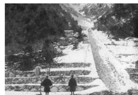
施工当時の宇曽川流路工
