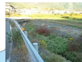
写真 藤ノ木川の河道内状況
