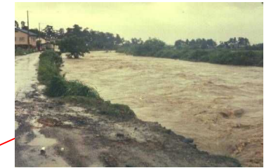
写真 真野川 昭和 51 年 6 月 県道高島大津線(旧:国道 161 号)下流 (大津市今堅田 3 丁目)での被害
