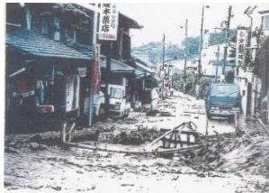
写真 藤ノ木川 平成 9 年 8 月 5 日 作り道(大津市坂本 4 丁目)での被害
