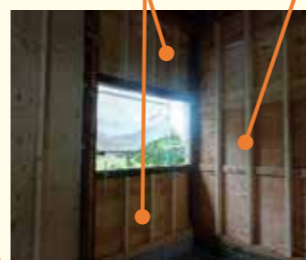
採光等を確保しつつ地震に耐える壁設置
