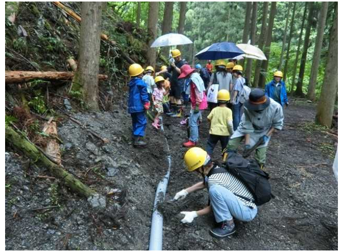
写真4 配水管の敷設風景
