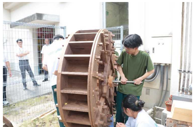
写真6 水車の設置の様子
