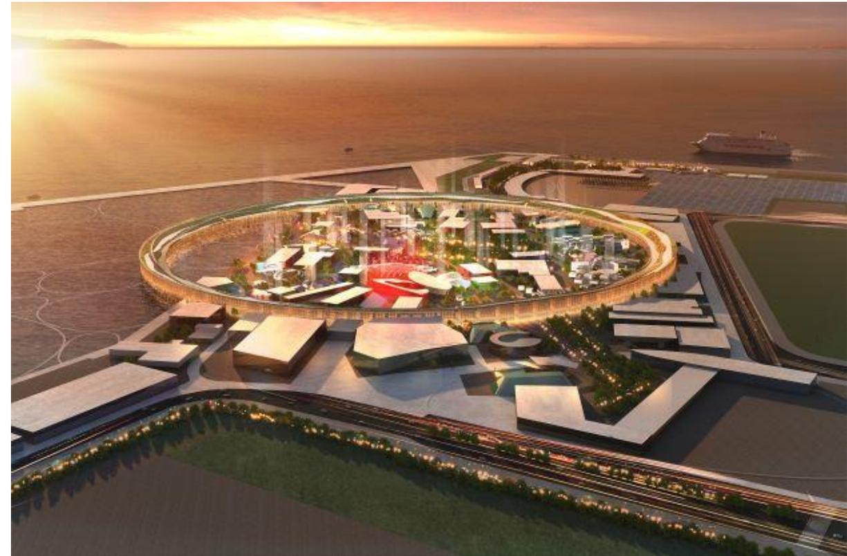
**リング：円周約2km、直径（内径）約610m、高さ内側12m・外側20m、幅30m**
