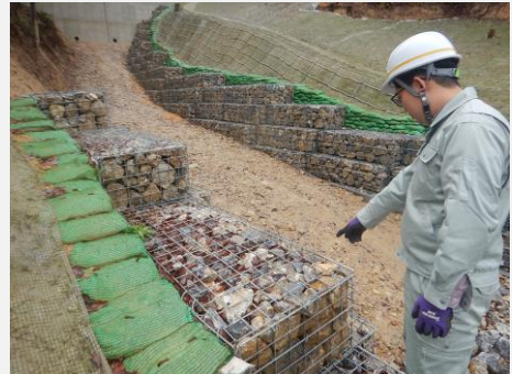
現場確認（羽尻技師提供）
