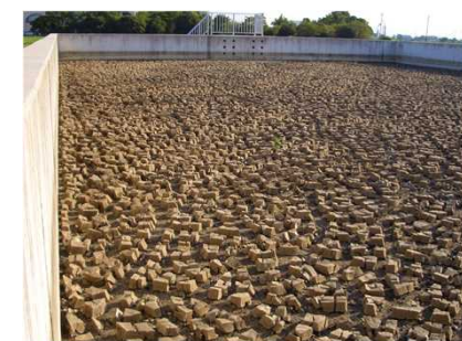
汚泥張込み 3箇月後
